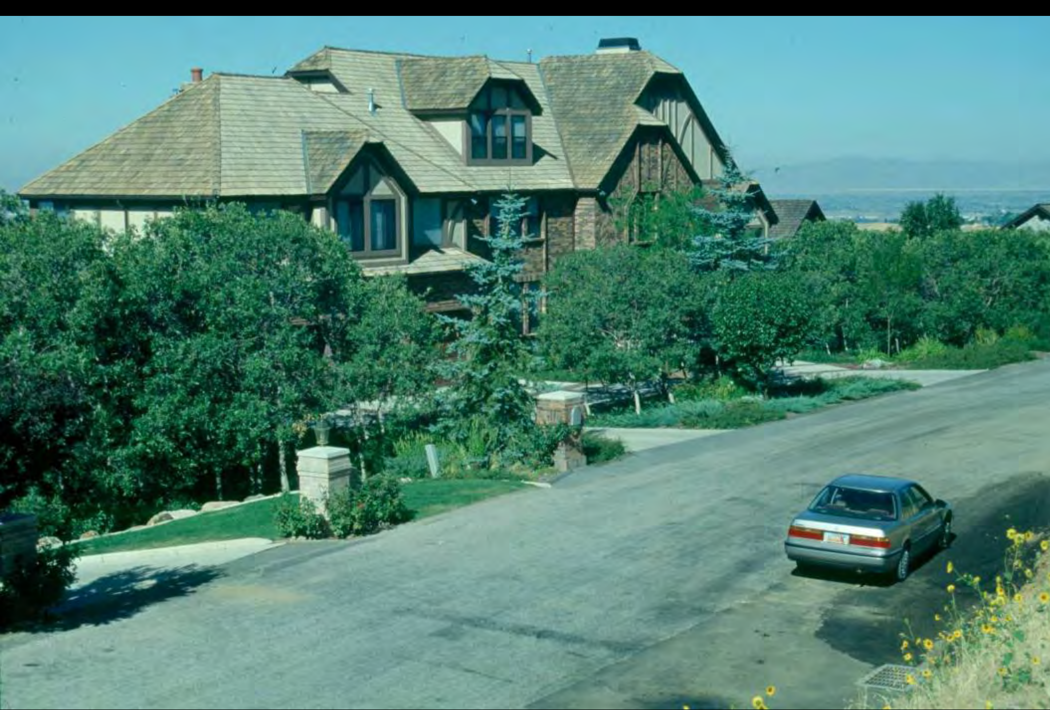
Wood roof (Uintah, UT)
